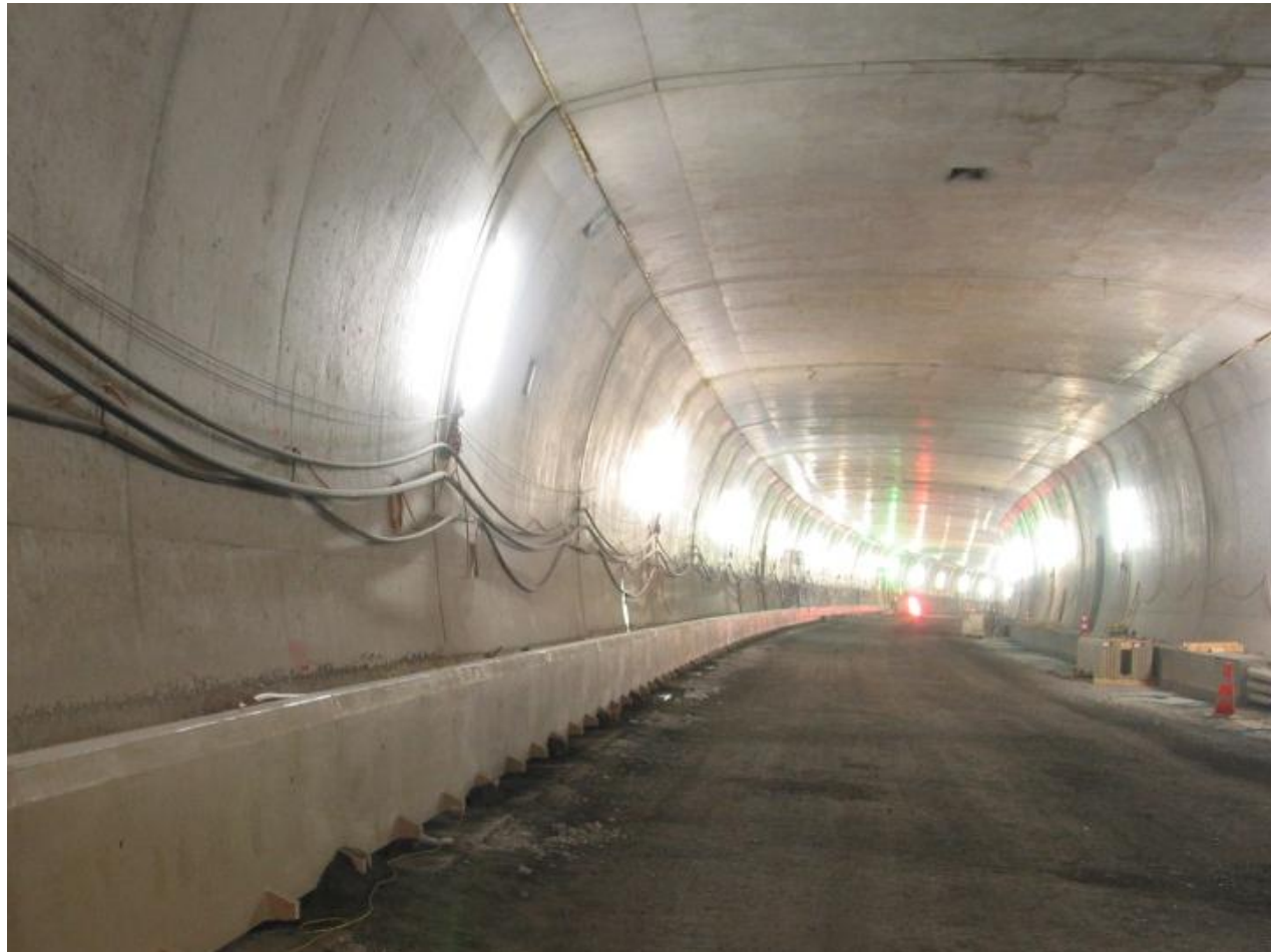
Tunnel-Umfahrung, Lungern (IIC)
